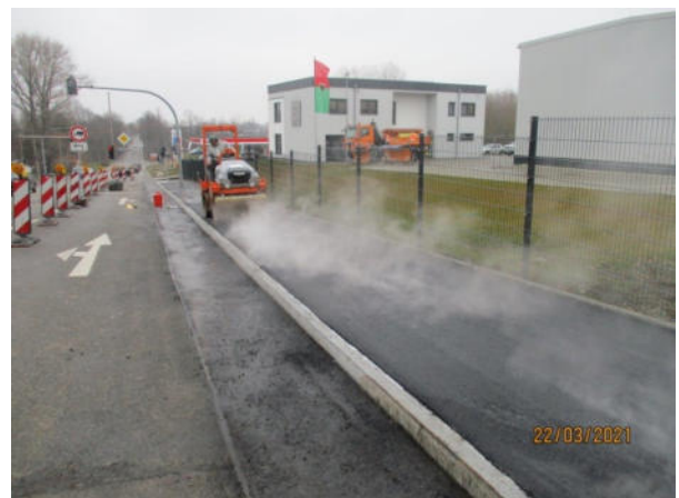
Gehweg an der Burgstädter Straße im Bereich des Bauhofes Quelle: Stadtverwaltung
