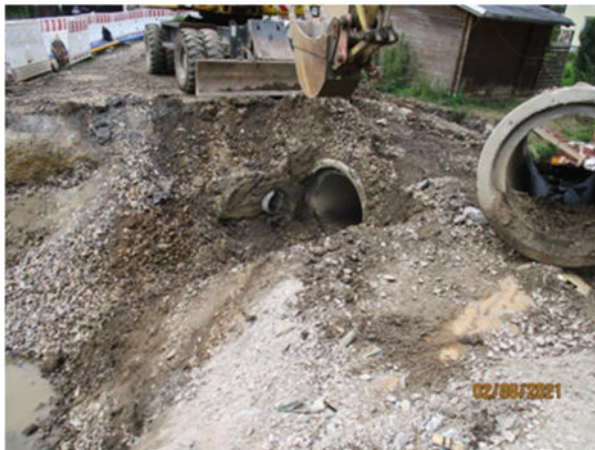
Rückbau Verrohrung Quelle: Stadtverwaltung
