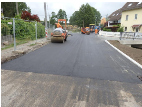
Durchlass „Zum Lindenhof“ – Asphaltinbau Quelle: Örtliche Bauüberwachung IWU GmbH
