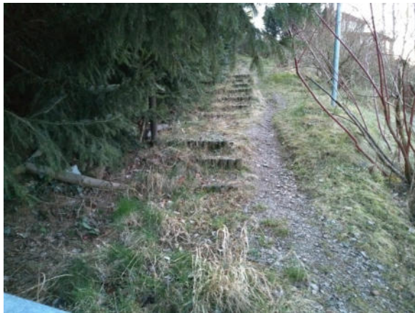
Bestand Treppenanlage Quelle: Stadtverwaltung
