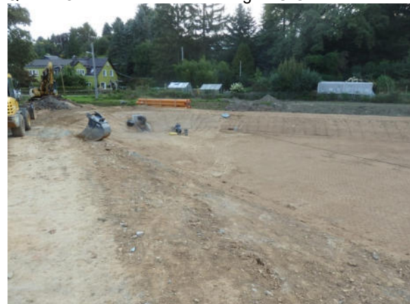
Einbau Teichdichtung Quelle: Örtliche Bauüberwachung IWU GmbH
