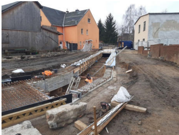
Durchlass unterhalb Löbelgässchen Quelle: Örtliche Bauüberwachung IWU GmbH
