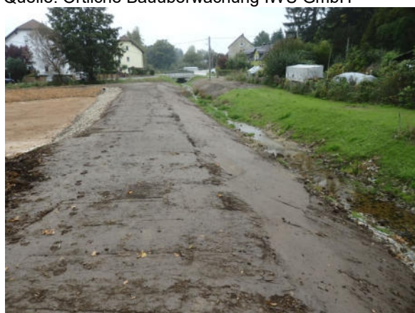
Teichdamm Quelle: Örtliche Bauüberwachung IWU GmbH
