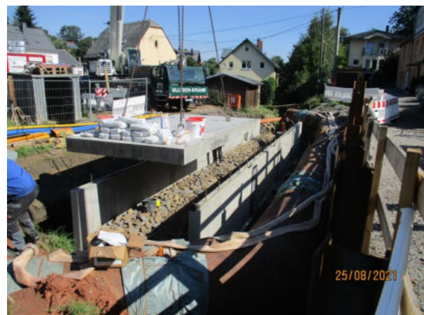
Neubau Durchlass Quelle: Stadtverwaltung
