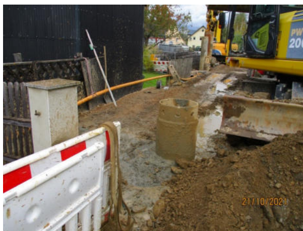
Bohrpfahlwand Quelle: Stadtverwaltung
