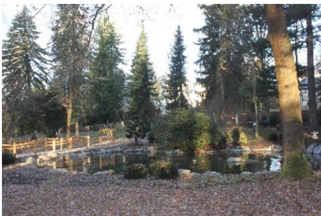
Seerosenteich nach der Sanierung/Uferbefestigung
