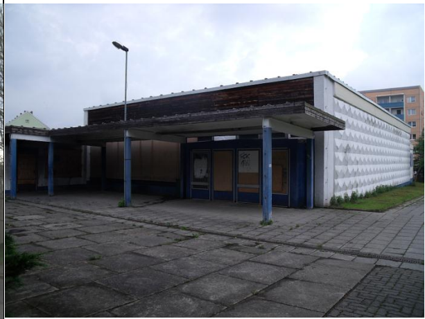
ehem. Kaufhalle Prof.-Willkomm-Straße 14
