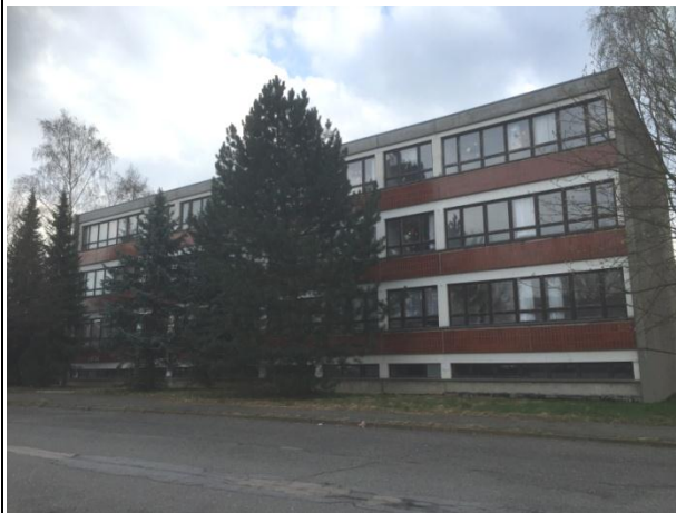
Grundschule mit Hort „Am Wasserturm“
