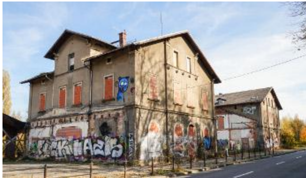
Sanierung: ehem. Bahnhof Limbach
