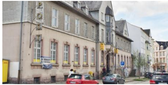
Moritzstraße 13, ehem. Post
