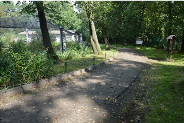
notwendige Sanierung/Instandsetzung des Wegenetzes
