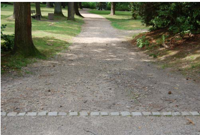
fehlende Einfassung, ausgespülte Deckschicht
