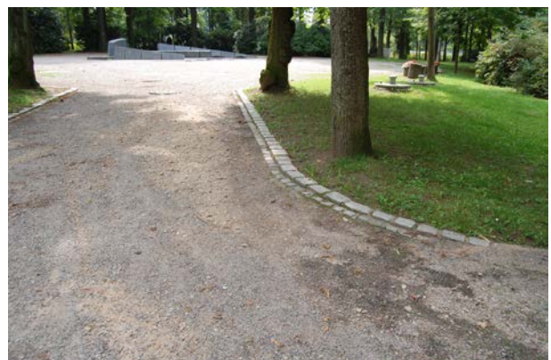
ausgespülte Deckschicht
