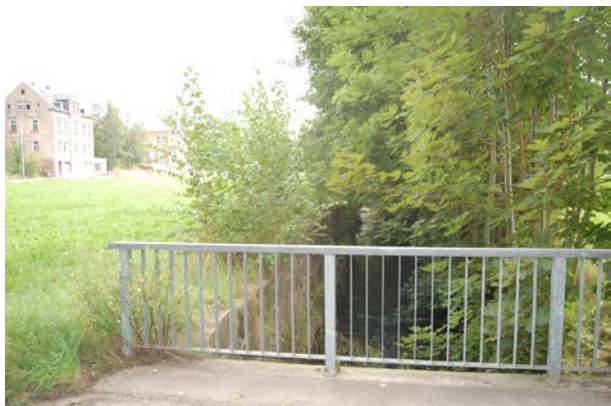
Brücke über Frohnbach
