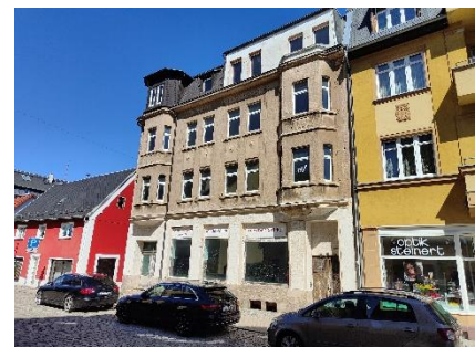
Komplettleerstand eines Gebäudes an der Helenenstraße
