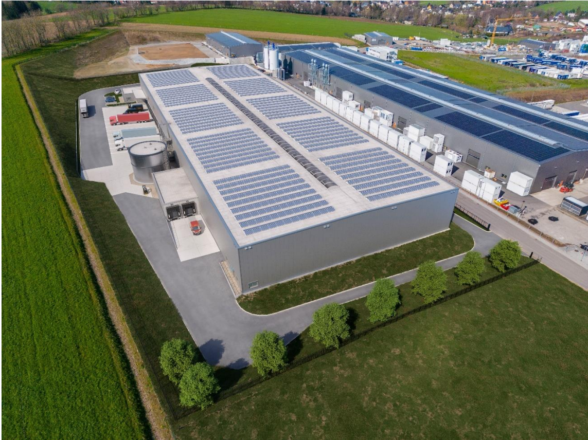
Ansicht der Ostseite
