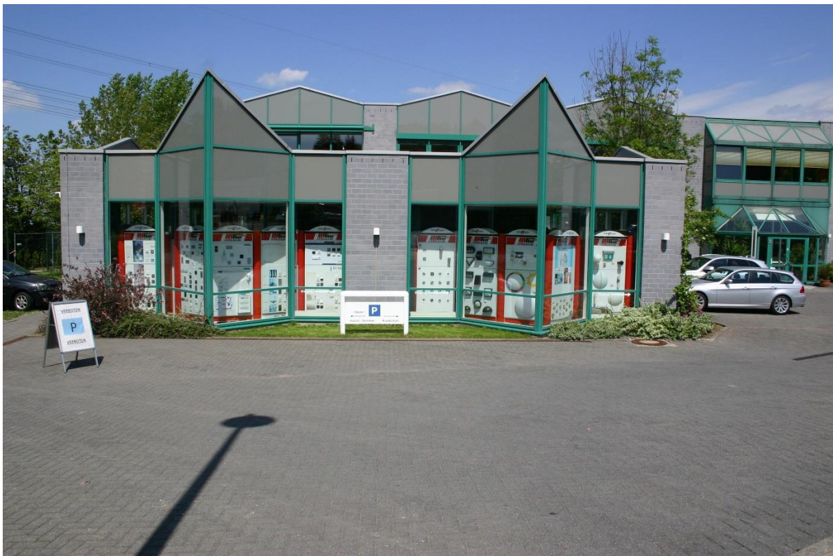
Ansicht Zufahrt PKW von der Zeppelinstraße Südseite
