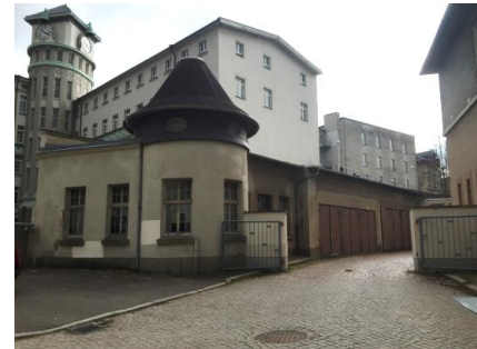
Teilleerstand Turmpassage und ehem. Post
