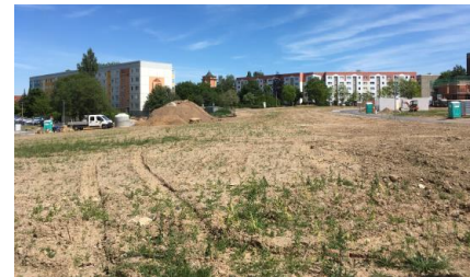
Abbruchflächen im Wohngebiet am Wasserturm
