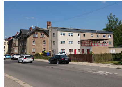
Entsiegelungs- und energetisches Ertüchtigungspotenzial bei Sanierung kommunaler Gebäude, z. B. Kita Spatzennest
