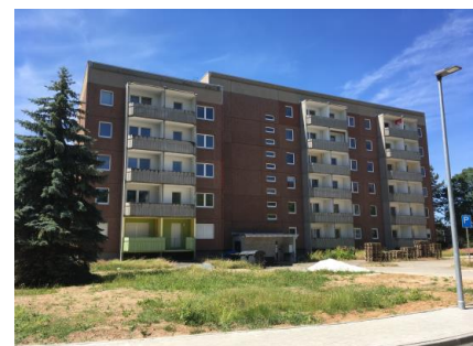
leerstehende Plattenbauten Heinrich-Mauersberger-Ring
