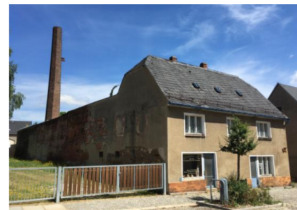
unsaniertes Wohn- und Fabrikgebäude Helenenstraße
