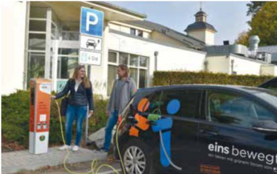
Seit 13. Oktober ist nun auch auf dem Parkplatz vorm Tierpark das Laden von E-Autos möglich. Dieses neue Angebot ergänzt die dort bereits vorhandene Station für E-Bikes. Errichtet wurde eine Ladesäule mit zwei Ladepunkten mit einer Leistung von je 22 kW zum Normalladen mit Wechselstrom. Die Abrechnung erfolgt am einfachsten über die kostenlose eins E-Mobil-App, die unter anderem eine Übersicht aller
