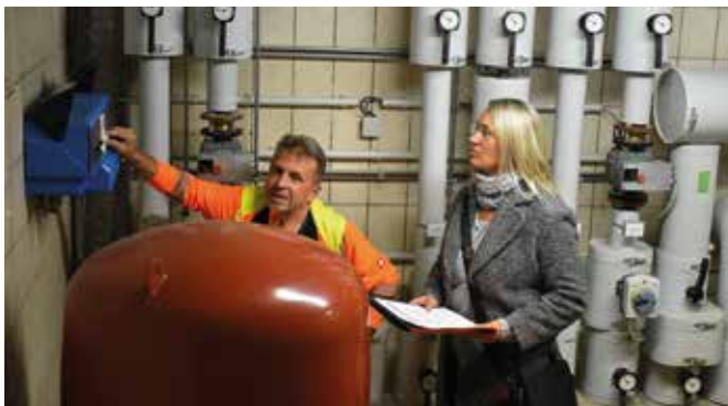
Klimaschutzmanagerin Kathrin Weise beim Abstimmen der Heizungseinstellungen mit Klaus Gräbner, dem Hausmeister der Goethe-Grundschule.
