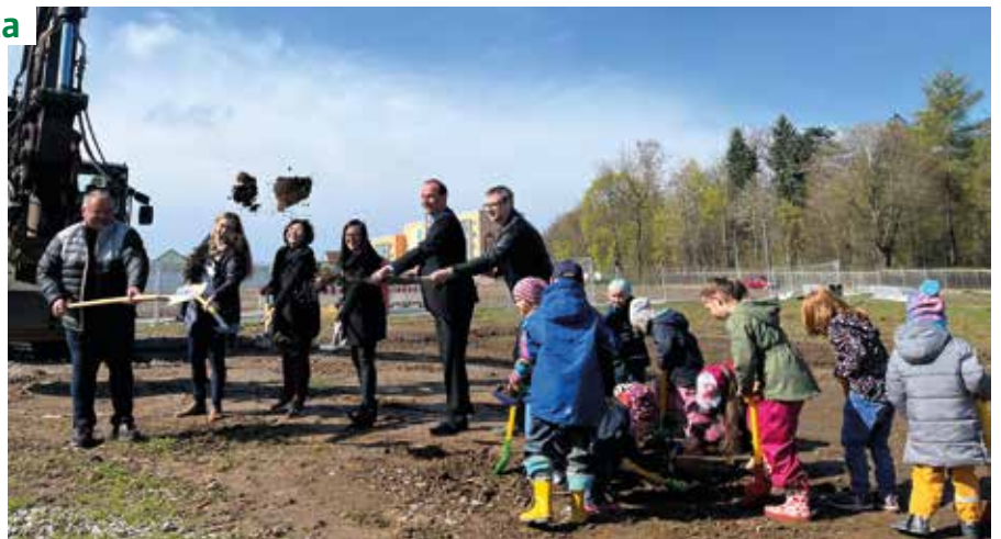
Gemeinsamer erster Spatenstich: Uwe Eichhorn, Tief- und Straßenbau GmbH Hartmannsdorf, Katja Bretschneider verantwortliche Mitarbeiterin der Stadtverwaltung, Kerstin Bochmann, Architekturbüro Bochmann, Ria Kliem, Architekturbüro Bochmann, Oberbürgermeister Gerd Härtig, Steve Fischer, Leiter der Kindertagesstätte (v.l.n.r.) sowie ihre kleinen Helfer. Die Kinder der Kita „Am Wasserturm“ waren voller Vorfreude und hatten ein kleines Programm vorbereitet und den Baubeginn tatkräftig unterstützt. Dafür hatten sie extra ihre neuen Schaufeln mitgebracht.
