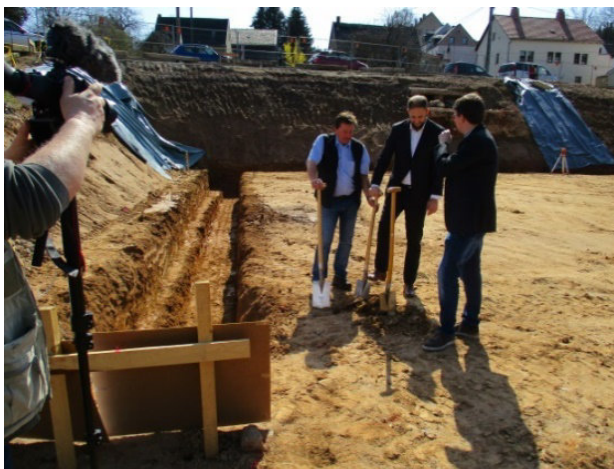
10. April 2018 – 1. Spatenstich für den Turnhallenneubau
