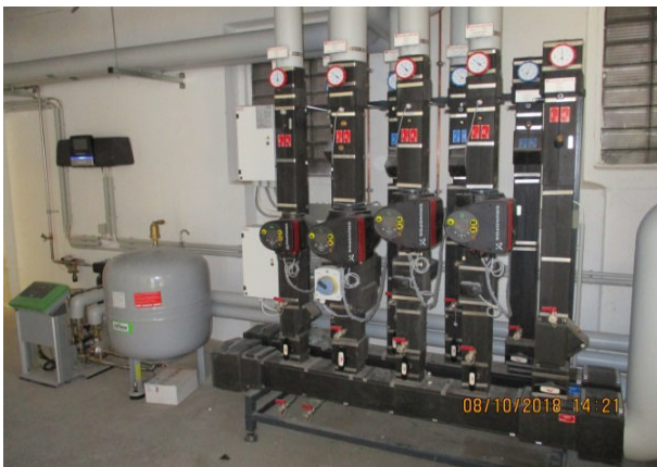
Heizverteiler
